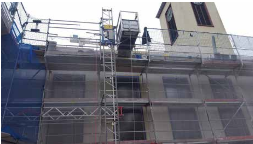
Die Dachdecker sind eifrig am Werk
