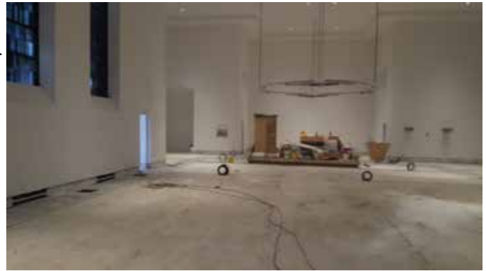
Innenansicht - noch ohne neuen Fußboden
