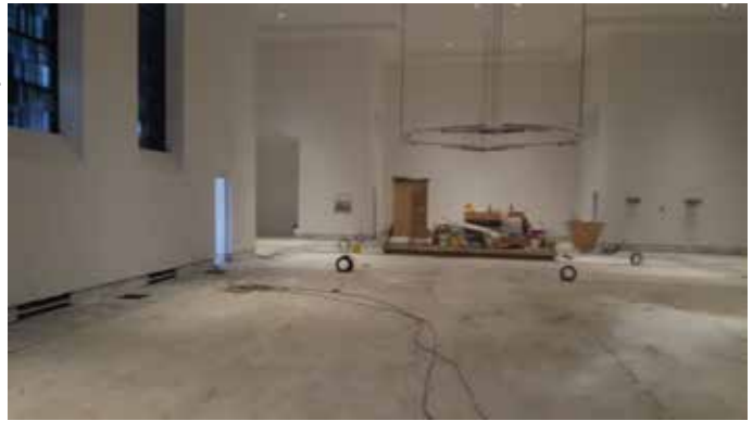
Innenansicht - noch ohne neuen Fußboden
